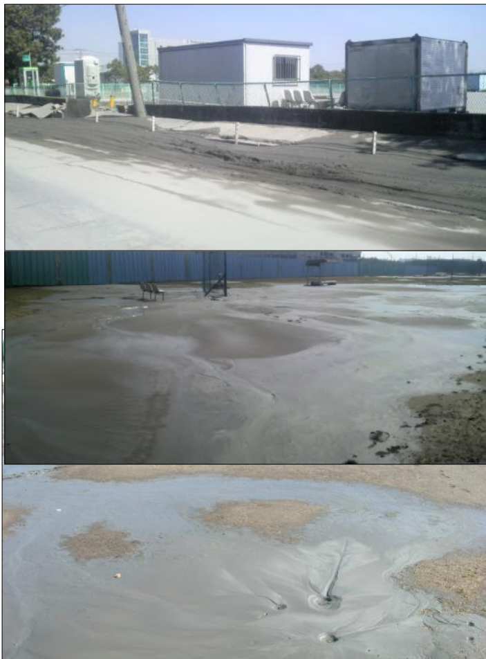
高瀬グラウンドの液状化の状況(3月13日撮影)
